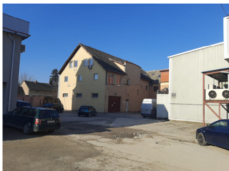
Постојеће стање објекта бр.1
