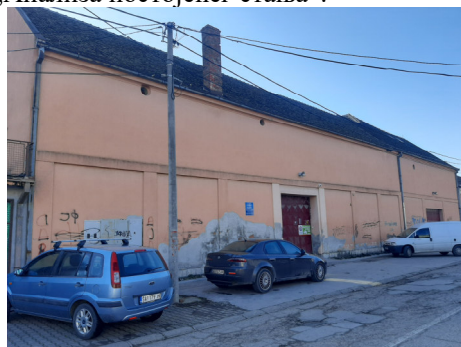
Постојеће стање објекта бр.2
