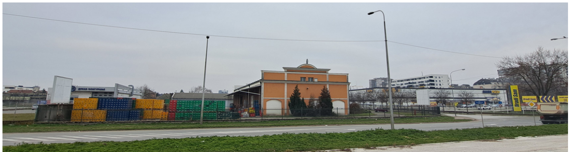
Постојеће стање: изглед из улице Јанка Веселиновића
