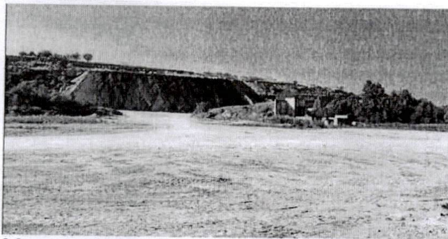
Слика 3: Започети радови на уклањању откривке, поглед са приступног платоа (август 2024.)
