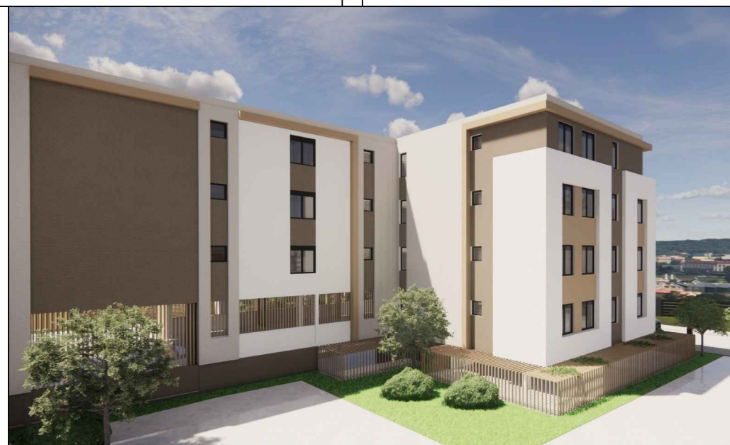
POGLED IZ ULICE VOJVODE MIŠIĆA KA DVORIŠTU
