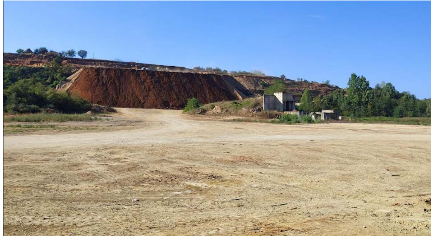
Слика 4: Започети радови на уклањању отквивке, поглед са приступног платоа (август 2024.)
