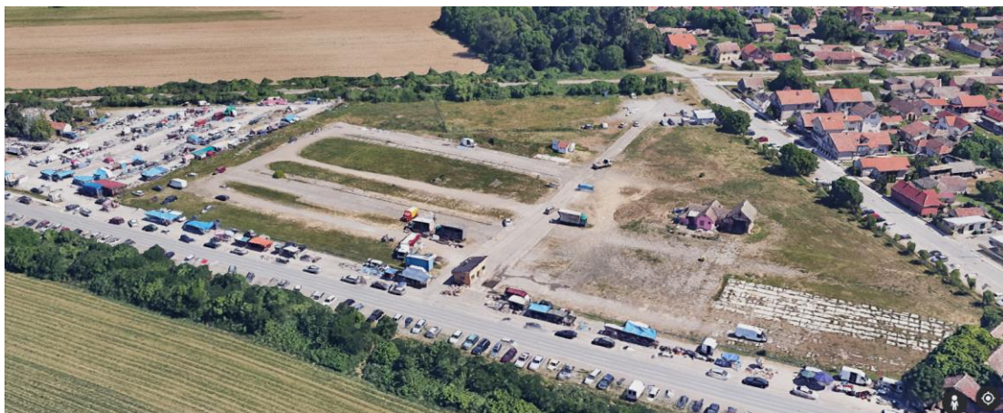
Слика 4: Приказ постојећег стања површина на кат.п.бр. 1162 - пијаце ( https://earth.google.com/ )
