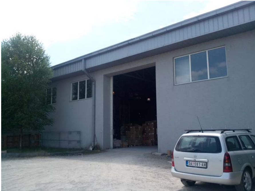
Слика 7: Објект складишта
