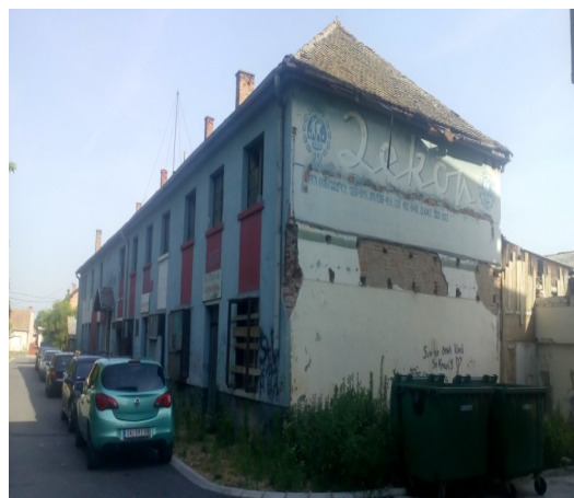
Slika 2 - Izgled lokacije iz ulice grada Argostolija (objekat koji je uklonjen)
