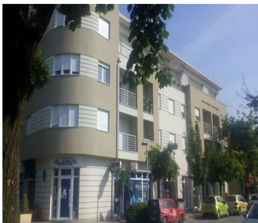
Slika 1 - Izgled lokacije iz Masarikove ulice (postojeći objekat koji se zadržava)
